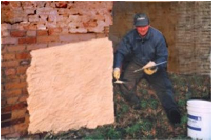
Fig. 1 - Estrazione e rimozione di vecchi sali nitrati da muro di stalla già intonacato a calce nel Trevisano con il bio-estrattore cocoon.
