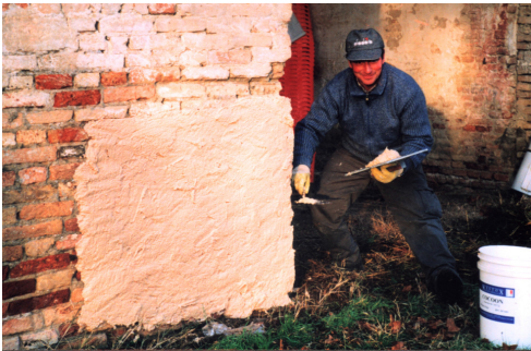
Fig. 1 - Estrazione e rimozione di vecchi sali nitrati da muro di stalla già intonacato a calce nel Trevisano con il bio-estrattore cocoon.
